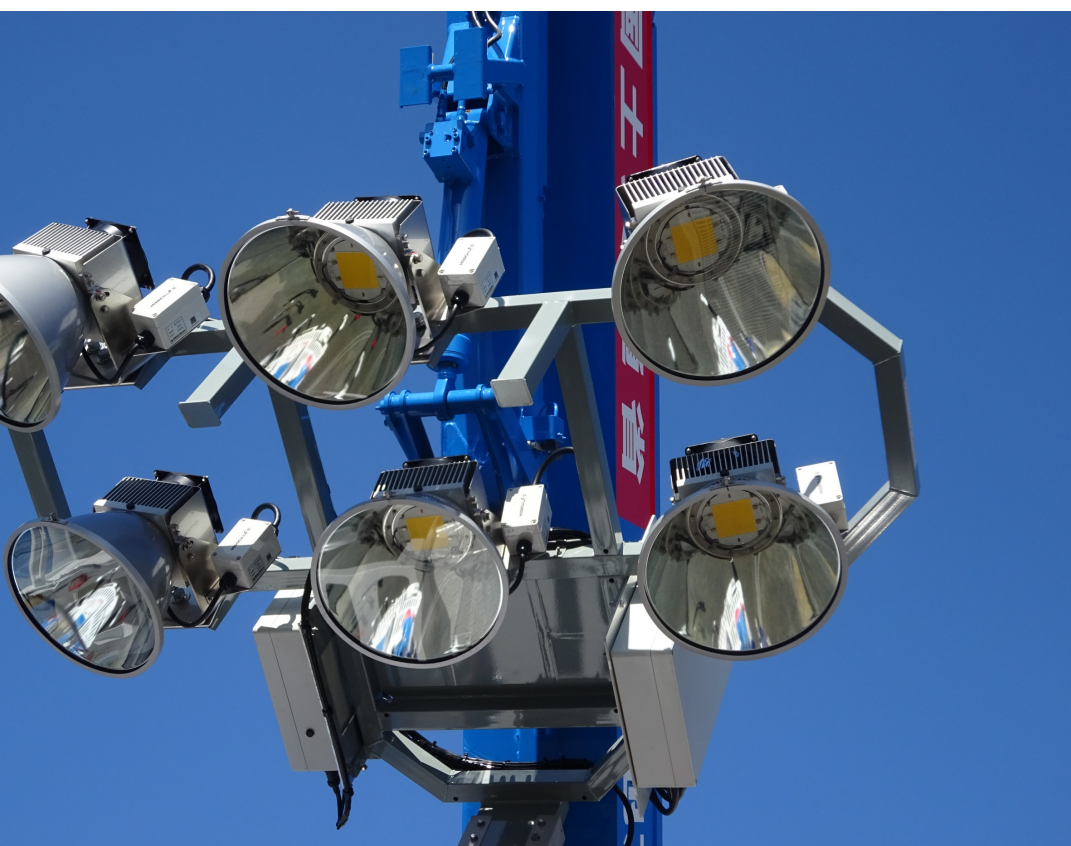
LED式照明装置 (1.2kW×6灯)
