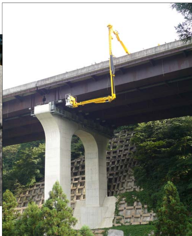
橋梁点検車(バケット式)による点検状況
