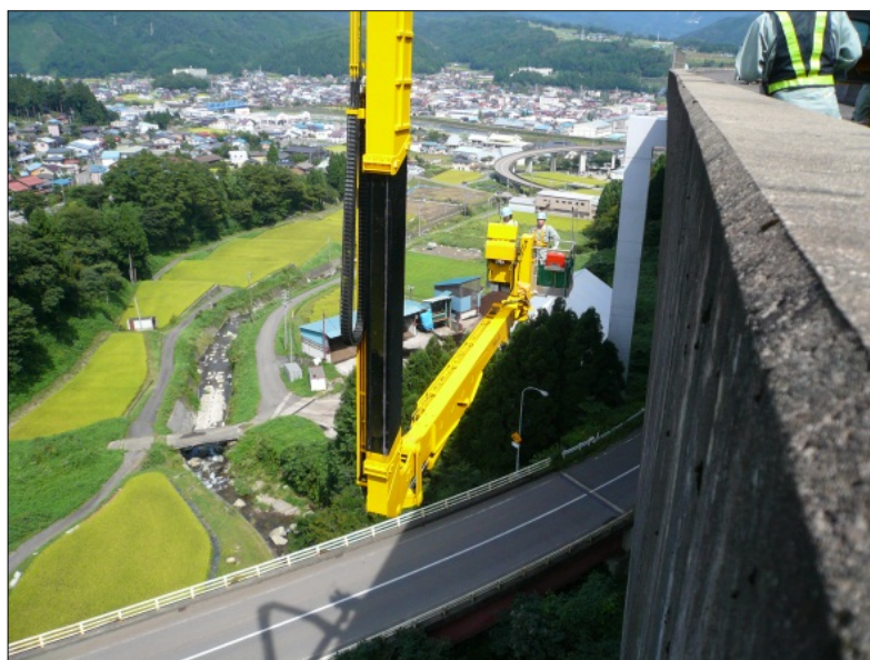
橋梁点検車(バケット式)による点検状況
