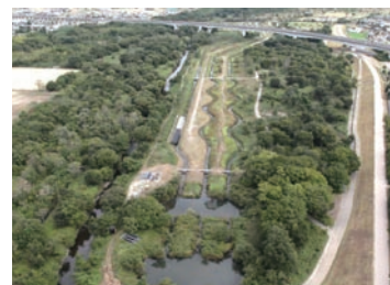
自然共生研究センター実験河川
