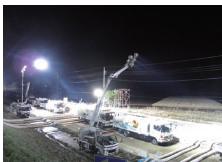
平成27年9月関東・東北豪雨(茨城県常総市) 排水作業(排水ポンプ車、照明車派遣)
