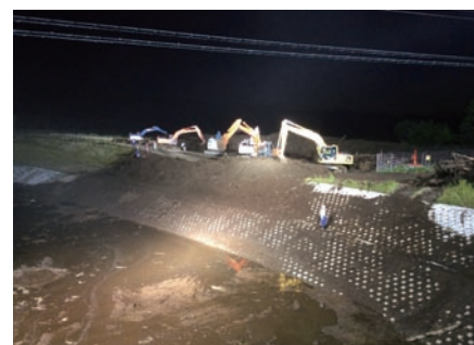
平成30年北海道胆振東部地震(北海道勇払郡厚真町) 河道閉塞土砂撤去作業(無人化施工バックホウ、照明車派遣)
