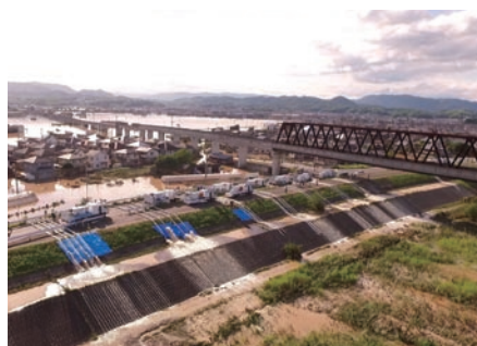
平成30年7月豪雨(岡山県倉敷市真備町) 排水作業(排水ポンプ車、照明車派遣)
