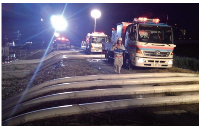
令和元年8月の前線に伴う大雨(佐賀県杵島郡大町町) 排水作業(排水ポンプ車、照明車派遣)
