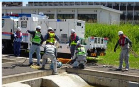
排水ポンプ車の設営訓練状況
