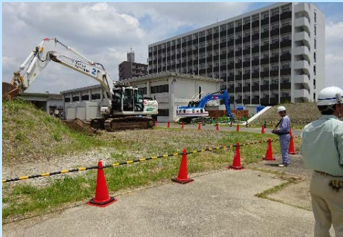
無人化施工バックホウの遠隔操縦の訓練
