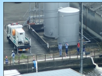
排水ポンプ車による排水作業
