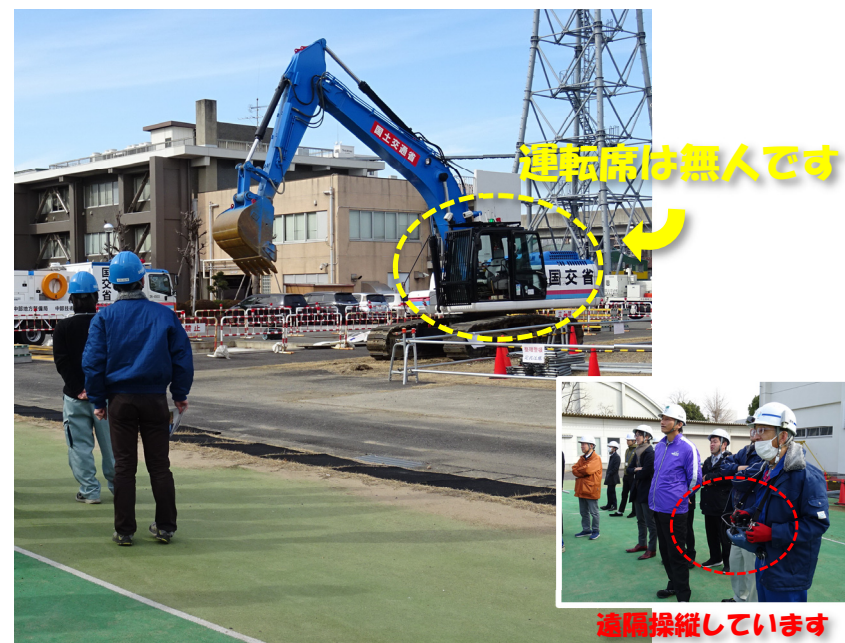
バックホウの遠隔操縦の見学
