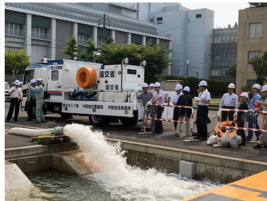
排水ポンプ車による排水状況の見学
