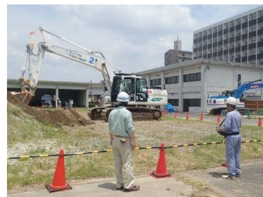
無人化施工バックホウの遠隔操縦訓練
