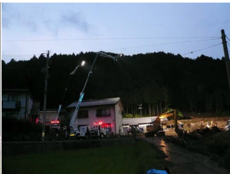
H22 岐阜県八百津町で発生した 土石流災害現場での照明支援
