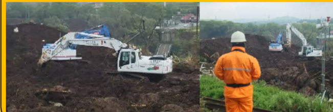
H28熊本地震での作業状況 遠隔操縦状況
