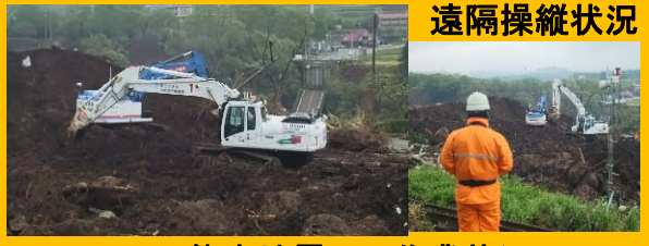
H28熊本地震での作業状況
