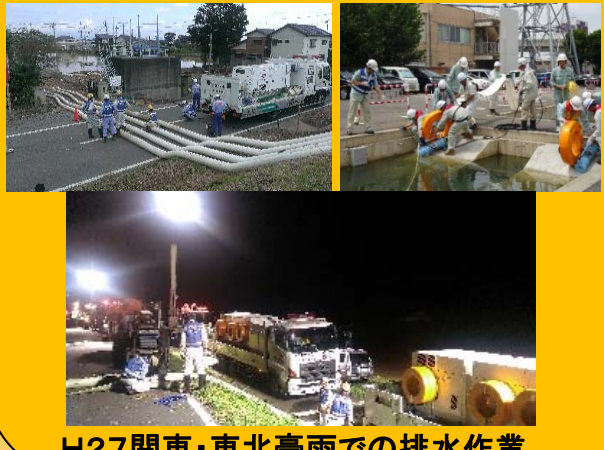
H27関東・東北豪雨での排水作業
