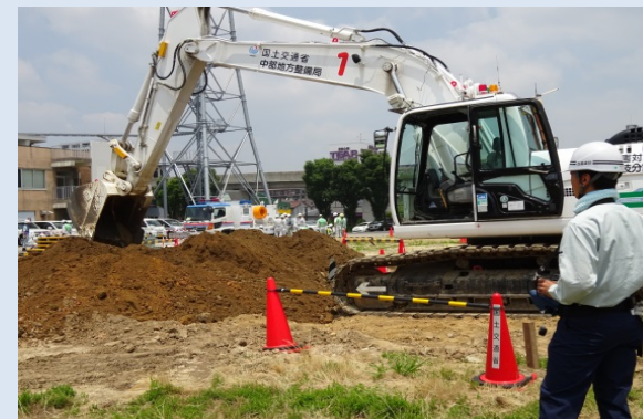
無人化施工バックホウ遠隔操作訓練
