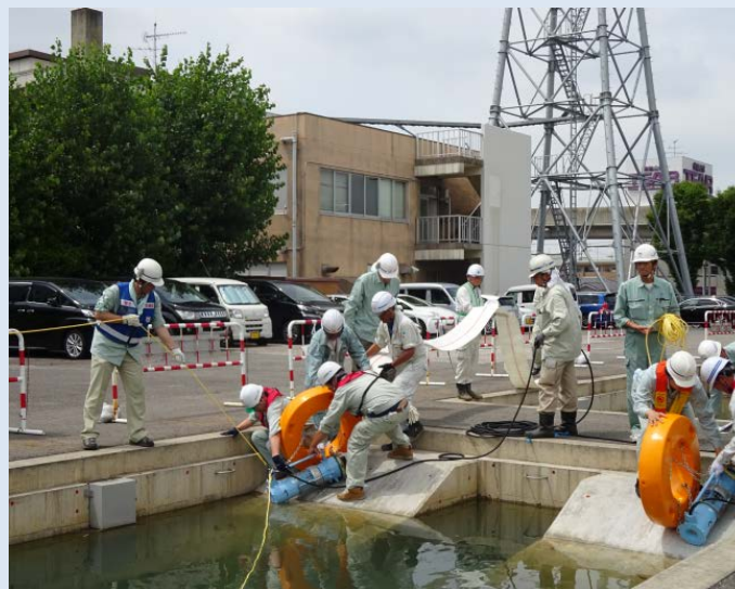
排水ポンプ車設置操作訓練
