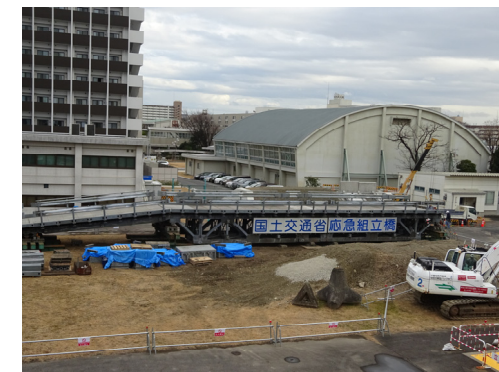
点検の為に架設中の応急組立橋
