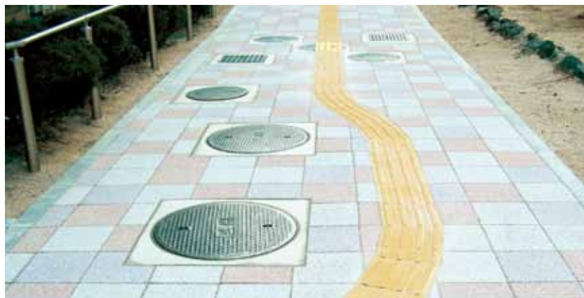
マンホールを迂回させて誘導ブロックを設置した例
