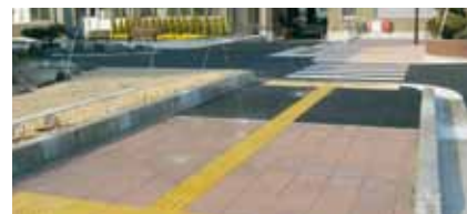
上：アスファルト 下：コンクリートブロック
