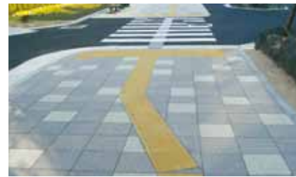
斜めの誘導ブロック
