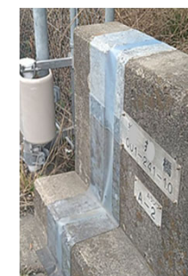
防水シリコン粘着シートによる簡易止水事例
