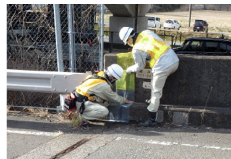
防水シリコン粘着シートによる簡易止水事例
