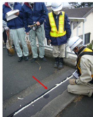
発砲ウレタンの充填材による簡易止水事例
