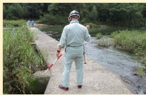
コンクリート橋（沈下橋）の現地調査
