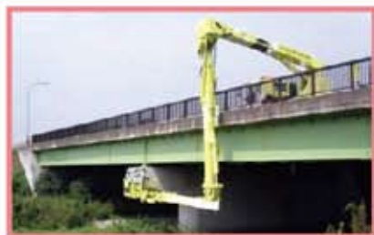
定期的に点検し、損傷状況を把握。
