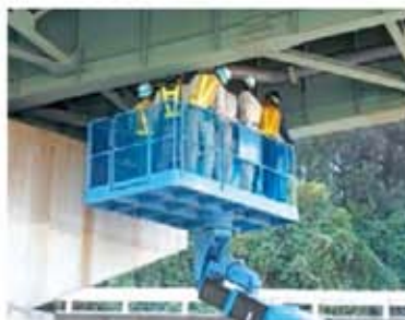
鋼橋点検状況
