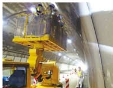
トンネル点検実習状況
