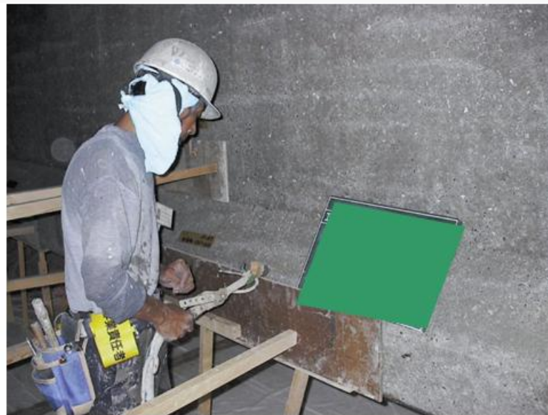
モルタル注入工法施工状況
