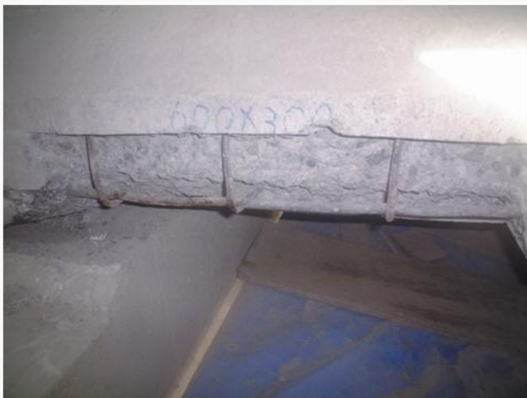
劣化部分撤去完了状況
