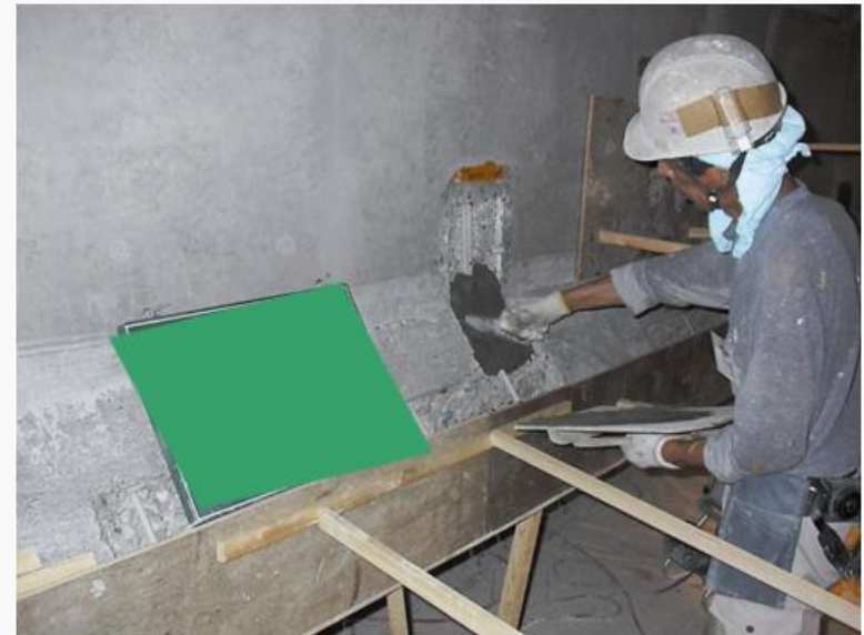
左官工法施工状況
