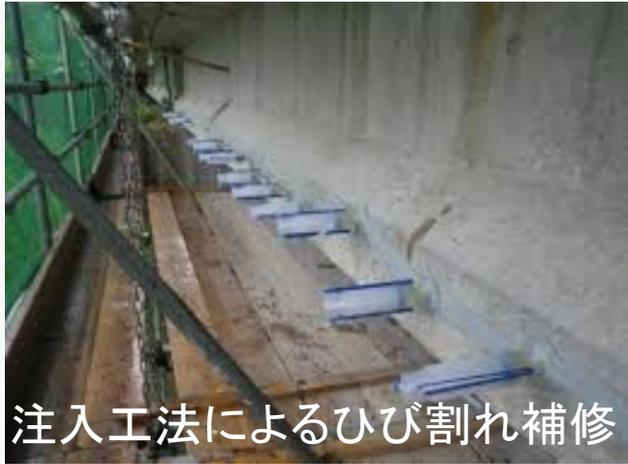
注入工法によるひび割れ補修
