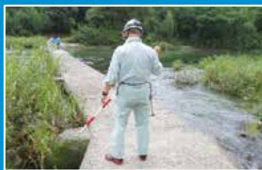
コンクリート橋(沈下橋)の現地調査
