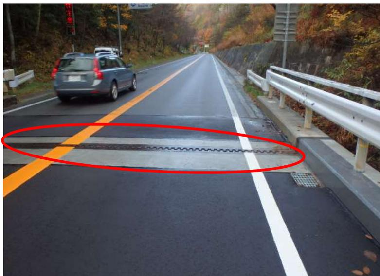
伸縮装置の交換による止水措置
