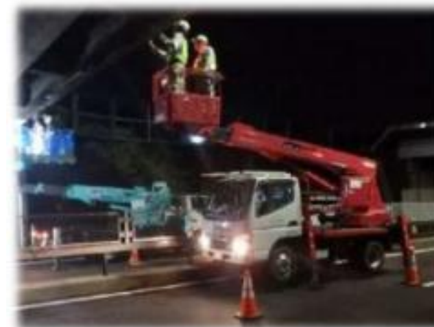
橋梁近接目視点検
