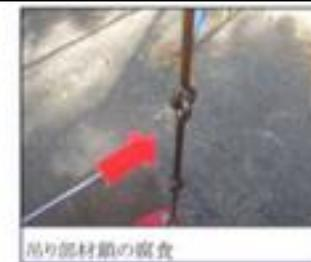
吊り部材部の腐食
