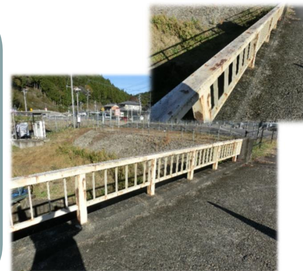
本イベントの施設状況 (飯高橋)
