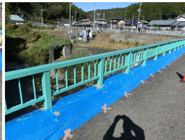
塗装補修完了
