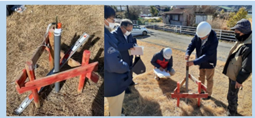
【観測井戸での試行状況】
