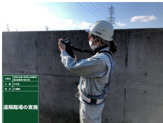
【立会状況（現場側）】
