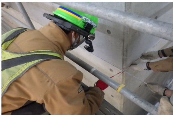
【立会状況（現場側）】
