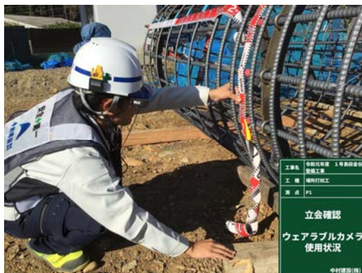
確認状況(現場)
