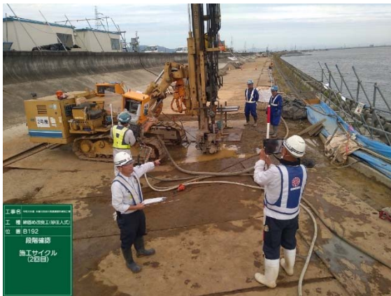
確認状況(現場)
