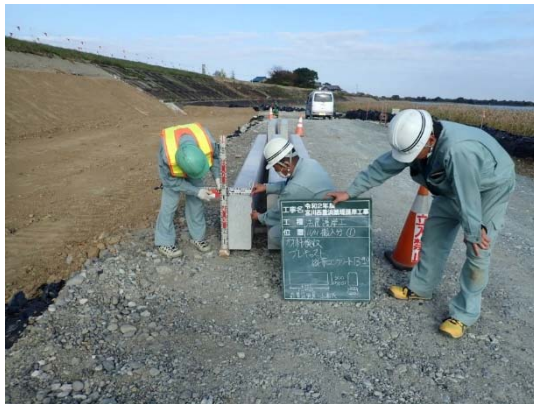
確認状況(現場)
