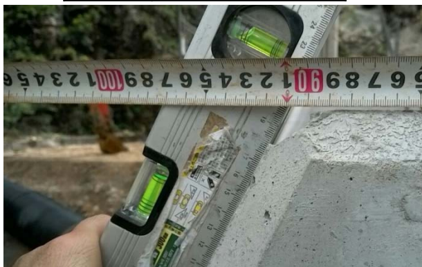
確認状況(現場)
