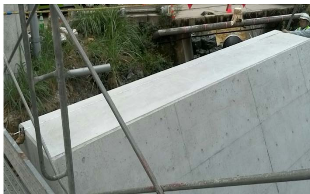
確認状況(現場 2)
