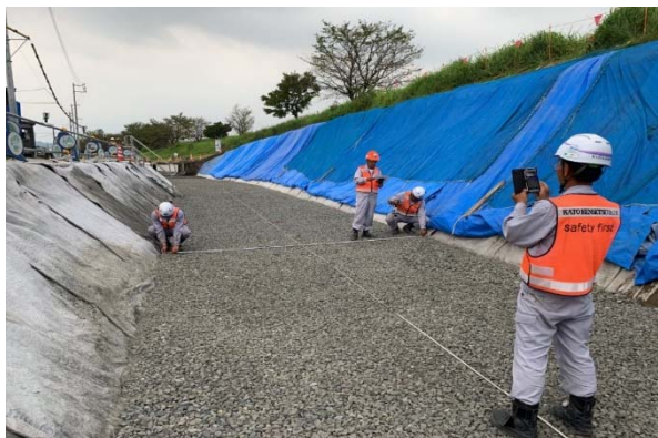
確認状況(現場)
