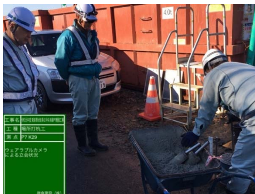
確認状況(現場)
