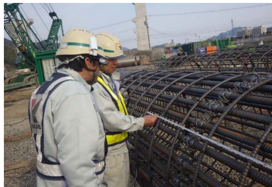
確認状況(現場)
