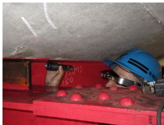
確認状況(現場)
