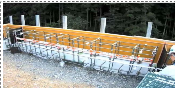
確認状況(現場)
