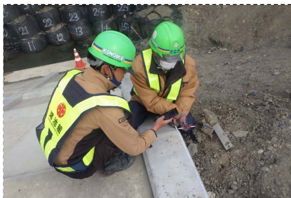
確認状況(現場)
