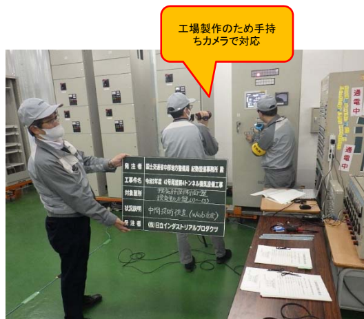
確認状況(現場)
