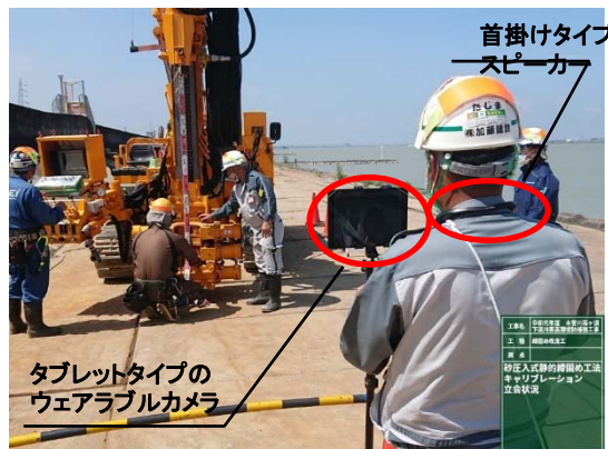
確認状況(現場)
