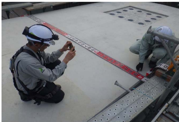
確認状況(現場)
