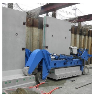
中央壁タイプ(据付状況)
