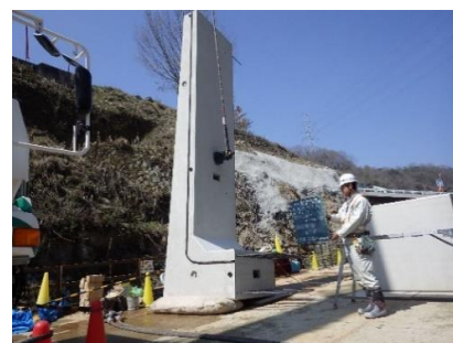
プレキャスト擁壁搬入状況
