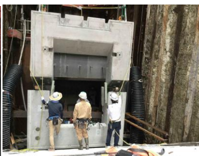
プレキャスト部材設置
