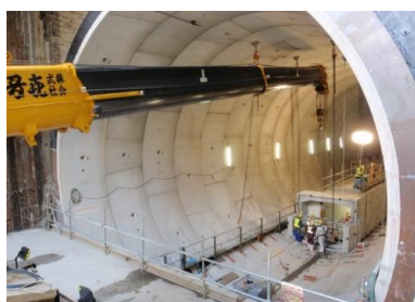
クレーン仮設状況
