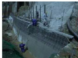
擁壁工 外壁の埋設型枠
