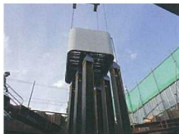
橋梁下部工 橋脚部の埋設型枠
