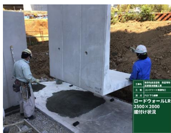
据え付け状況
