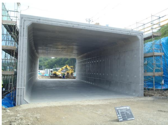
ボックスカルバート敷設完了
