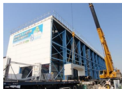
プレキャスト部材搬入状況
