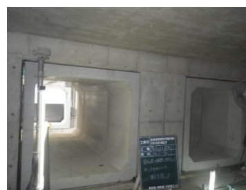
据付完了（躯体内）
