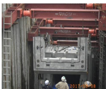
プレキャスト部材設置
