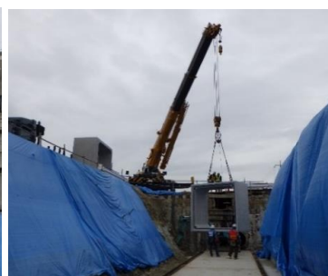
プレキャスト部材設置状況
