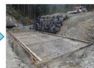
レール設置・基礎ブロック型枠設置状況
