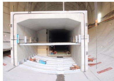
プレキャスト部材設置完了状況
