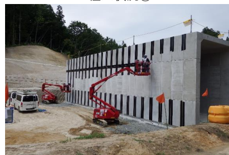
組立状況②
