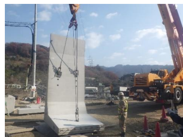
L型擁壁据付状況
