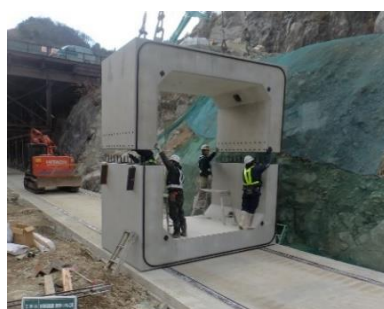
上部材設置状況
