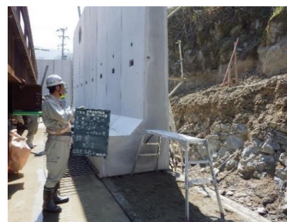
プレキャスト擁壁据付状況
