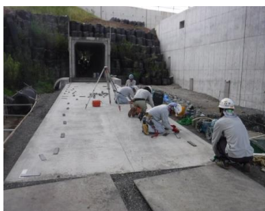
プレキャスト据付準備
