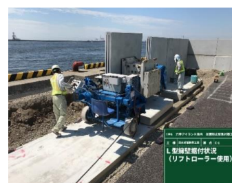
据付状況（リフトローラー使用）
