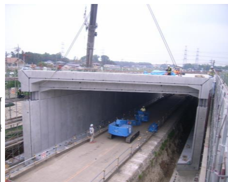
写真-プレキャスト部材架設状況
