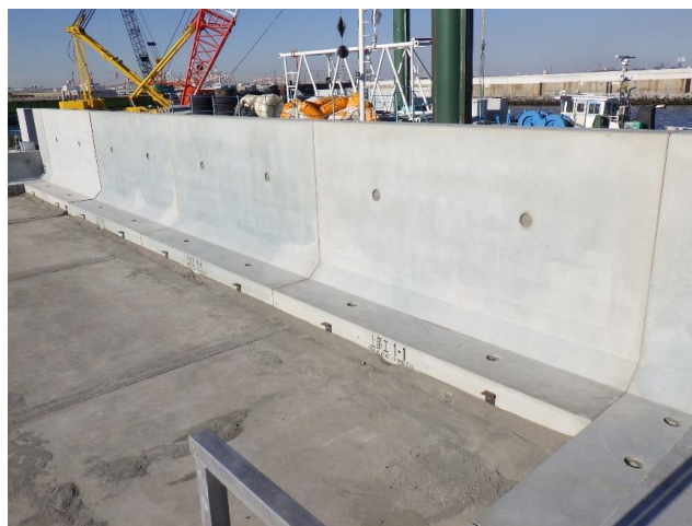
写真 設置完了時
