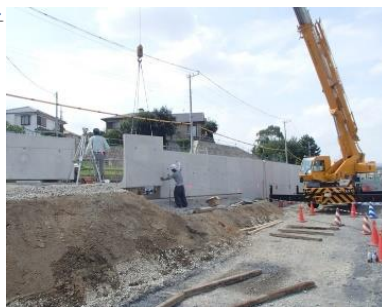
プレキャスト部材据付
