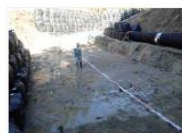
基礎地盤（立会確認）
