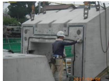
プレキャスト部材設置
