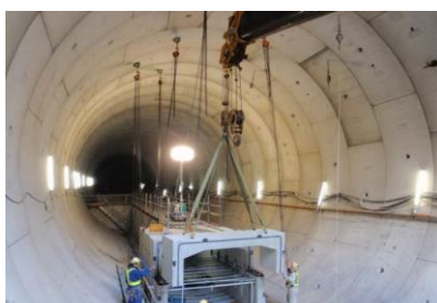
クレーン仮設状況
