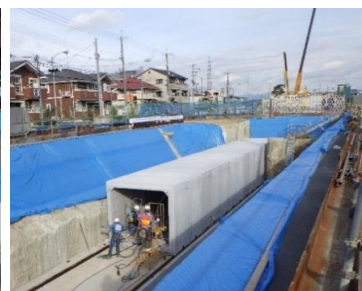
プレキャスト部材設置完了
