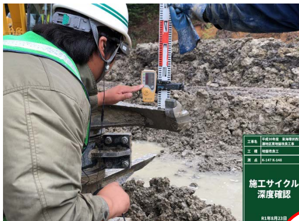
立合状況(現場) (段階確認 改良深度確認)
