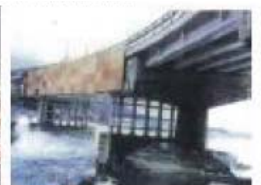
1991年(26年経過): 耐荷力確保のために 新たに2基の支柱を設置
