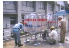
地元自治体の要望により、給水タンクを地元中学校に設置(日本道路建設業協会中部支部他)
