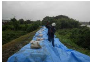
庄内川堤防洗掘箇所において、被害の拡大防止のため、応急処置として大型土のうを設置(建設業協会他)
