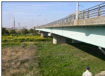
23号塩浜大橋(着手前)(四日市市塩浜)
