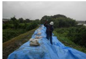
庄内川堤防洗掘箇所において、被害の拡大防止のため、応急処置として大型土のうを設置(建設業協会他)
