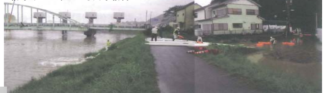
三重県紀宝町鮎田地区において、24時間体制で排水ポンプ車による内水排除を実施(日本建設機械化協会中部支部他)
