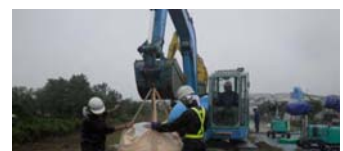
昼夜を徹して一刻も早い道路啓開作業を実施する
