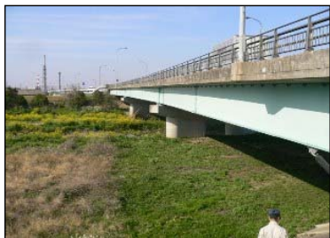
23号塩浜大橋(着手前) (四日市市塩浜) 58
