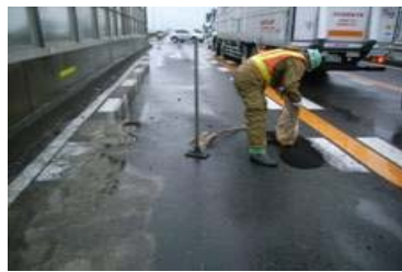
道路損傷の補修
