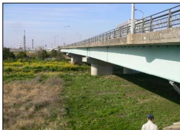
23号塩浜大橋(着手前) (四日市市塩浜) 58
