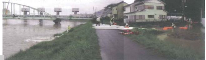
三重県紀宝町鮎田地区において、24時間体制で排水ポンプ車による内水排除を実施(日本建設機械化協会中部支部他)
