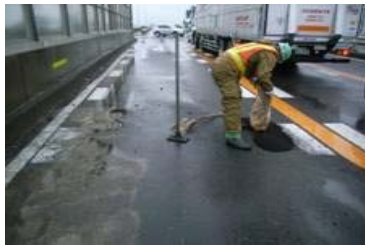
道路損傷の補修
