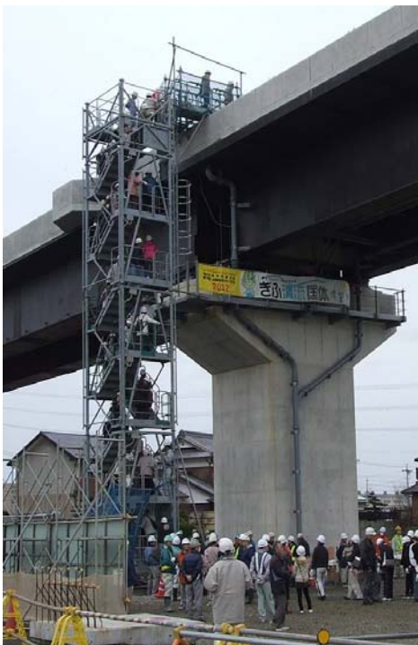
東海環状現場見学会: 岐阜県大垣市
