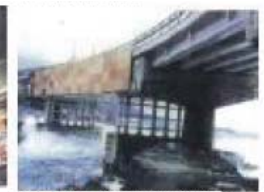
1991年(26年経過): 耐荷力確保のために 新たに2基の支柱を設置
