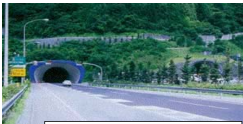
長大トンネル
