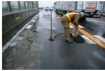
道路損傷の補修
