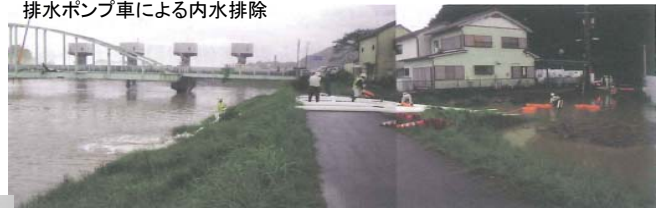
三重県紀宝町鮎田地区において、24時間体制で排水ポンプ車による内水排除を実施(日本建設機械化協会中部支部他)
