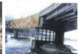
1991年(26年経過): 耐荷力確保のために 新たに2基の支柱を設置
