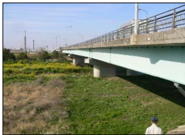
23号塩浜大橋(着手前)(四日市市塩浜)
