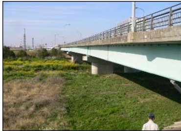
23号塩浜大橋(着手前)(四日市市塩浜)
