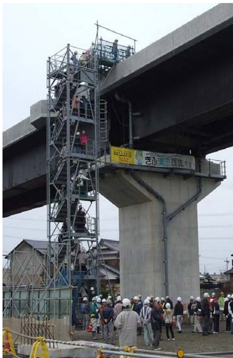
東海環状現場見学会: 岐阜県大垣市
