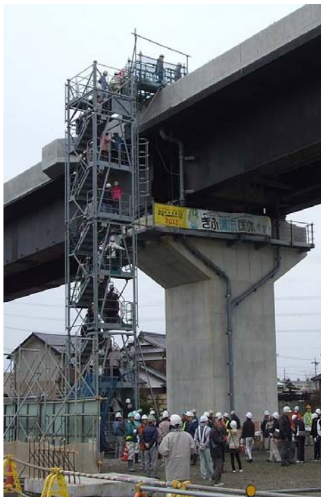
東海環状現場見学会: 岐阜県大垣市
