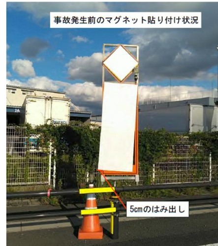
飛来した看板の写真
