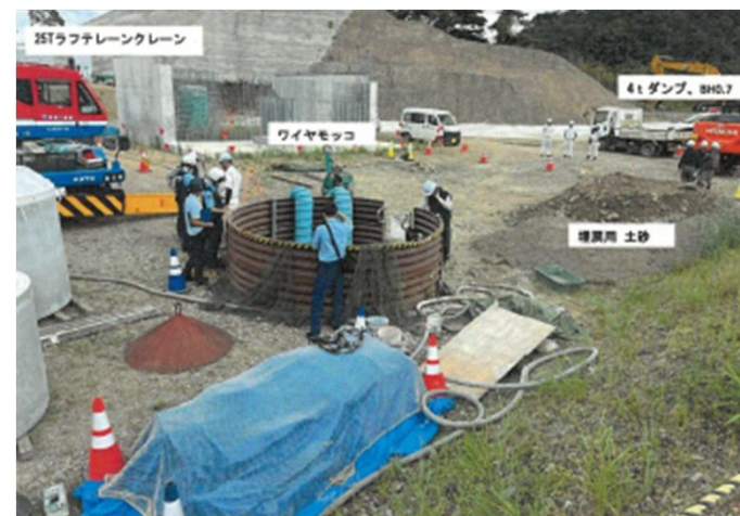
現場状況写真
