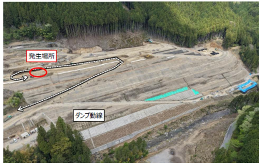
現場状況写真
