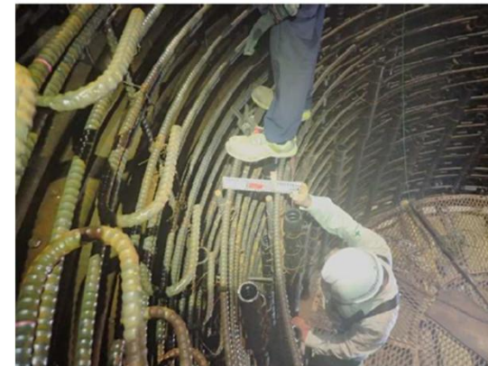
現場状況写真
