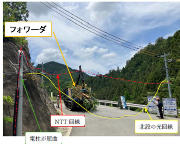
現場状況写真
