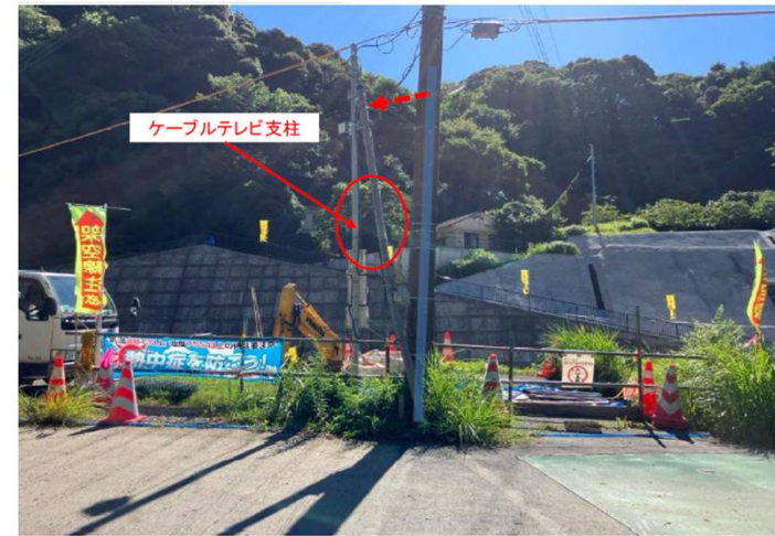
衝突した支柱写真
