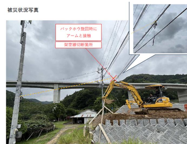
現場状況写真
