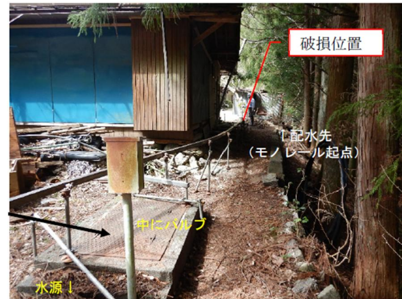
現場状況写真
