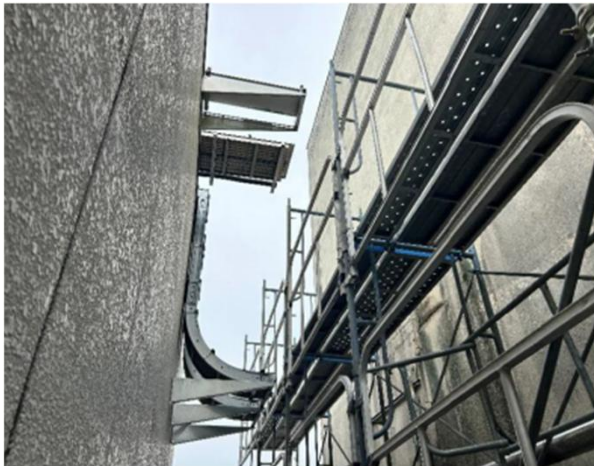
現場状況写真
