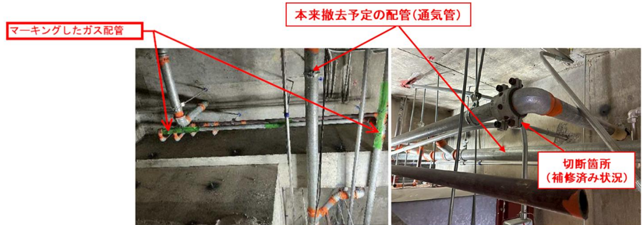
現場状況写真
