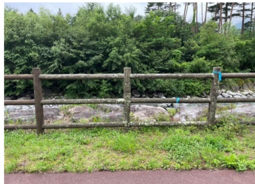
既設転落防止柵
