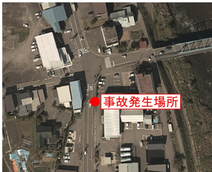
事故現場の周辺写真
