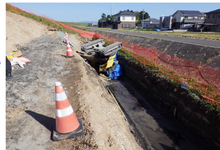
事故時の作業状況
