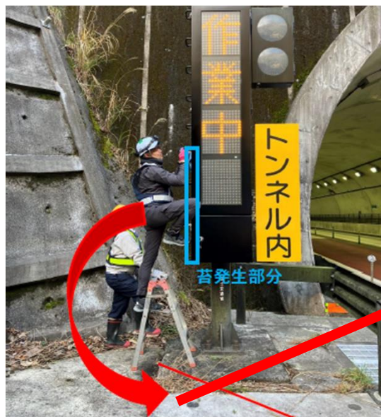
被災状況写真（再現：事故発生時は一人作業）
