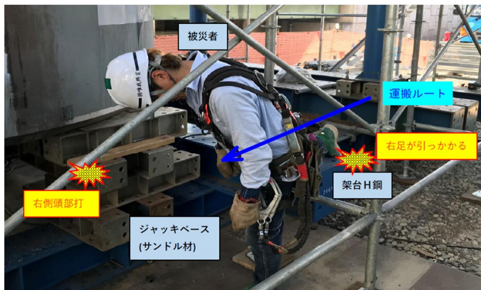
事故時の作業状況
