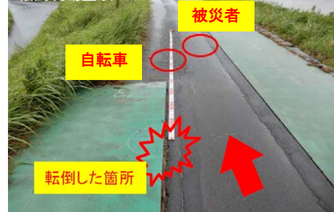
転倒した箇所の隙間
