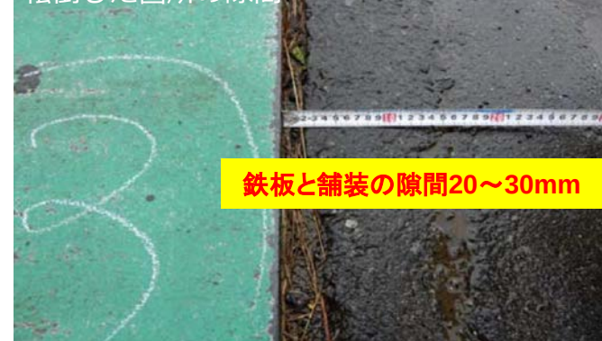
転倒した箇所の隙間
