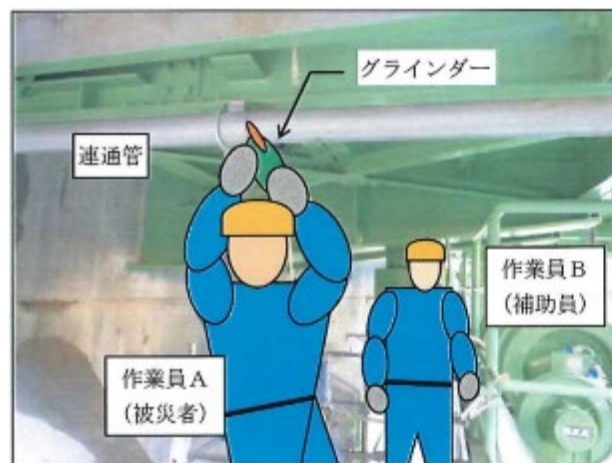
作業状況写真（再現）
