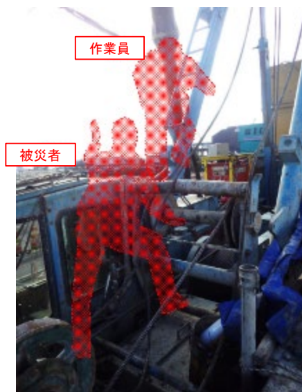
事故発生時の足場状況
