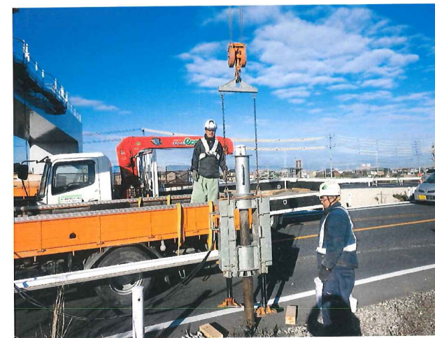
ガードレール撤去状況
