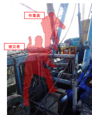
事故発生時の足場状況
