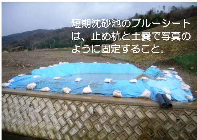
仮設沈砂池など設備。
