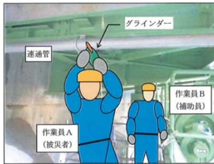
作業状況写真（再現）
