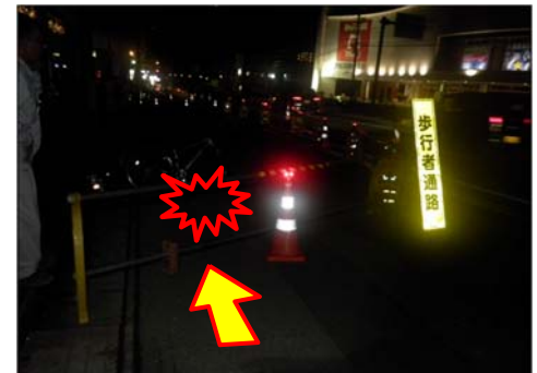
事故発生時の状況
