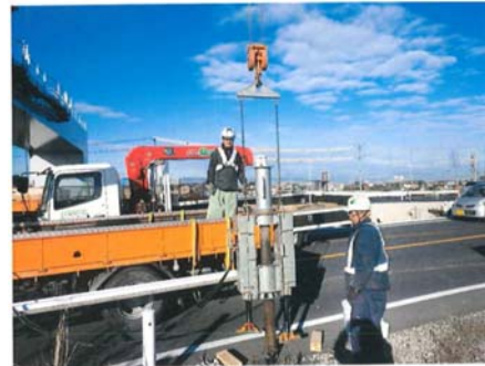
ガードレール撤去状況
