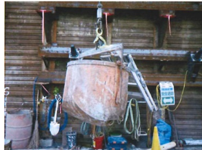
吊り荷(125kg) 機械式継手 グラウト材 脚立
