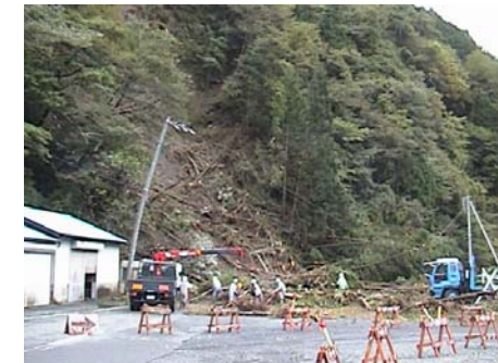
障害発生時の臨時点検 (設備の被災状況の確認等)
