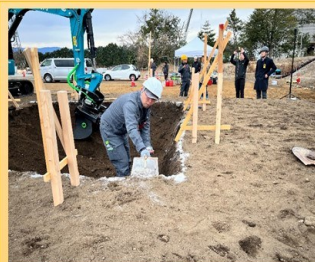
端部はスコップを用いて人力作業
