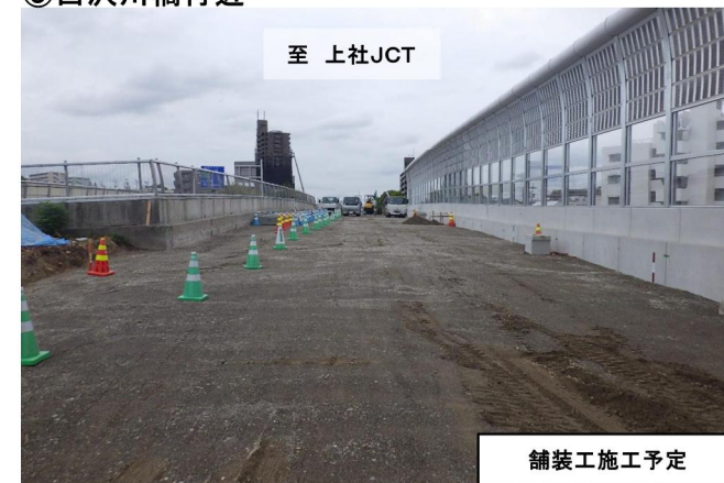
③白沢川橋付近
